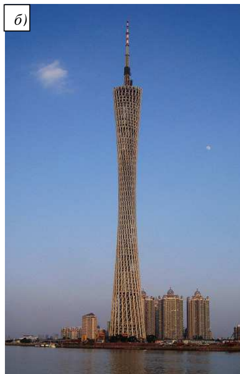
Рис. 1. Гиперболоидные конструкции: а - Первая гиперболоидная башня выполненная по проекту инженера В. Г. Шухова (Нижний Новгород, 189 бг.); б - Сетчатая гиперболоидная 610-метровая телебашня в Гуанчжоу (Китай)
