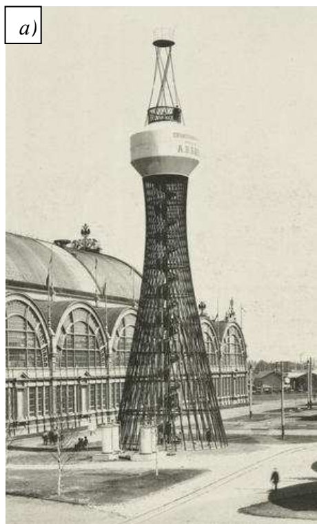
Рис. 1. Гиперболоидные конструкции: а - Первая гиперболоидная башня выполненная по проекту инженера В. Г. Шухова (Нижний Новгород, 189 бг.); б - Сетчатая гиперболоидная 610-метровая телебашня в Гуанчжоу (Китай)
