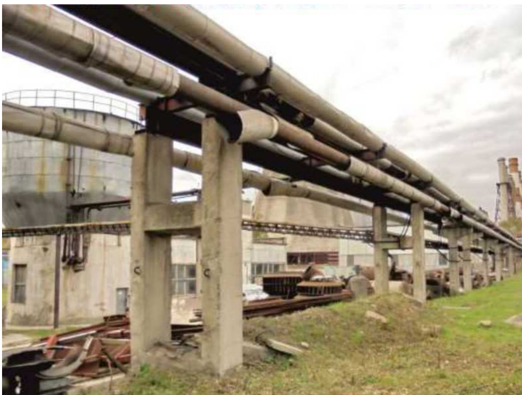
Рис 1. Эстакада мазутопроводов
